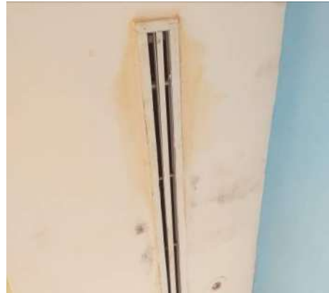
Figura 19. Manchas no forro na região dos difusores de ar condicionado
